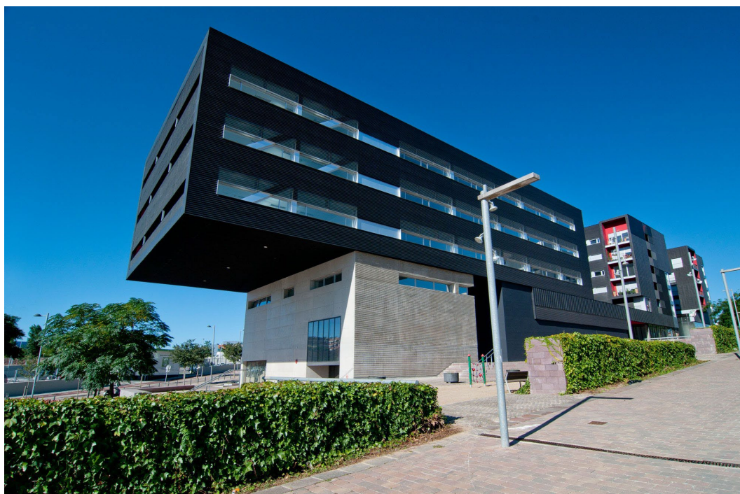
Abbildung 26: Sim4Blocks – Gebäude im Pilotstandort St Cugat (Spanien)
