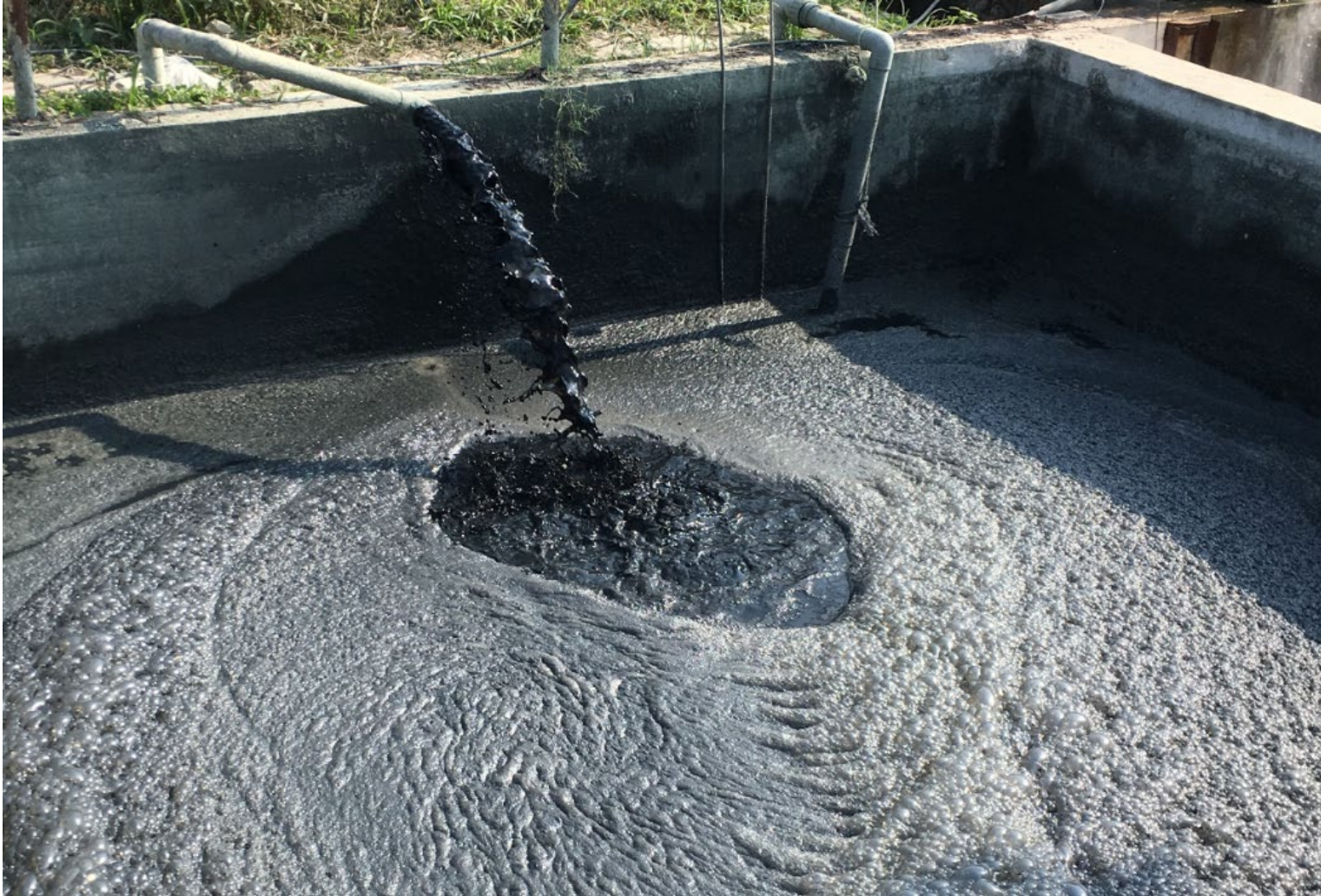
Foto: Sonja Bauer (Kläranlage in Vietnam)
